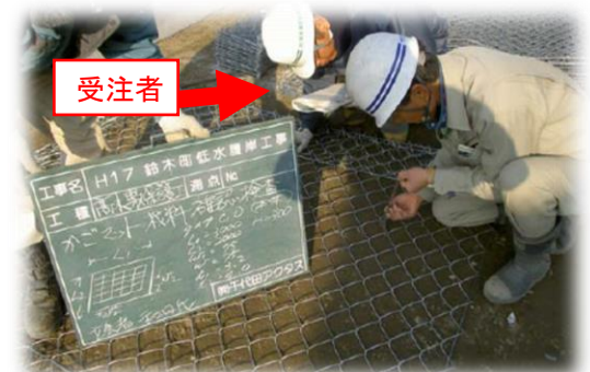
(河川護岸用かごマットの材料確認)
