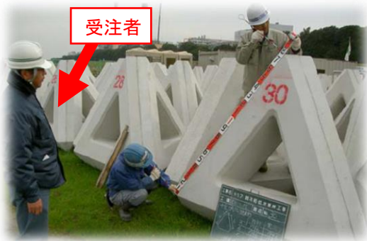
(根固めブロックの材料確認)
